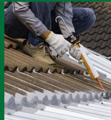
MANTENIMIENTO Y REVISIÓN DE TECHOS.
